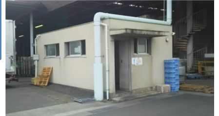
【下:丸統東側トイレ】
